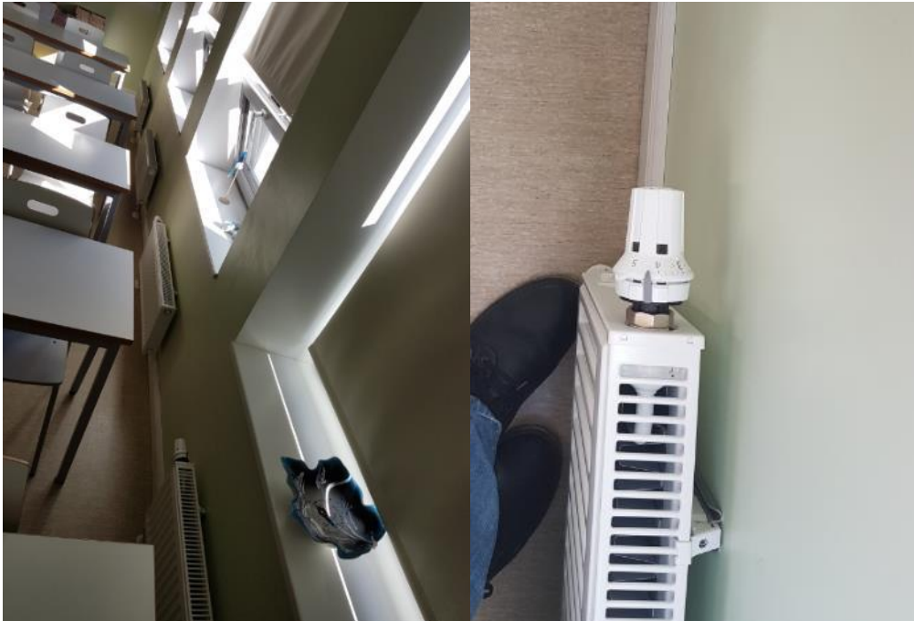
Joonis 3. Aknad on avatud ülekuumenemise tõttu ja radiaatorid kütavad
