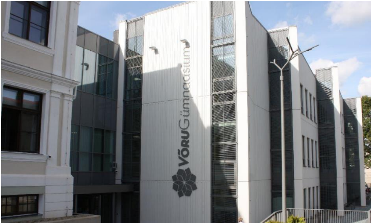
Joonis 1. Võru Gümnaasiumi renoveeritud osa (allikas https://lounaestlane.ee/wp-content/uploads/2017/11/voru-gumaasium.jpg )
